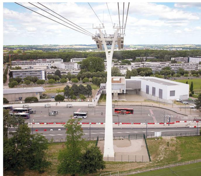
Abbildung unterschiedlicher Bauformen von Seilbahnstützen (Brest, Toulouse)
