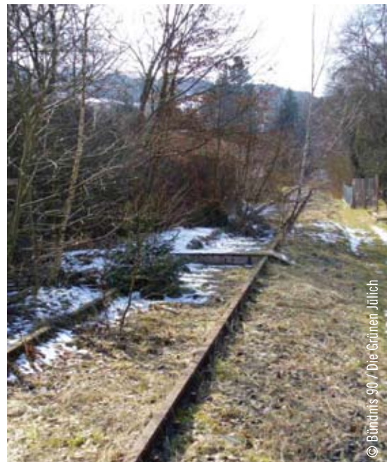
Stillgelegte Bahnstrecken ruinieren die Systemqualität
