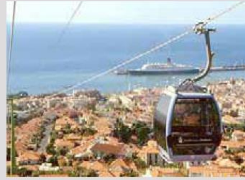
Kuppelbare Einseil-Umlaufbahn (MGD) Funchal, Portugal (PT)
