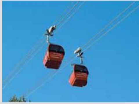
Kuppelbare Zweiseil-Umlaufbahn (BGD) La Massana, Andorra (AD)
